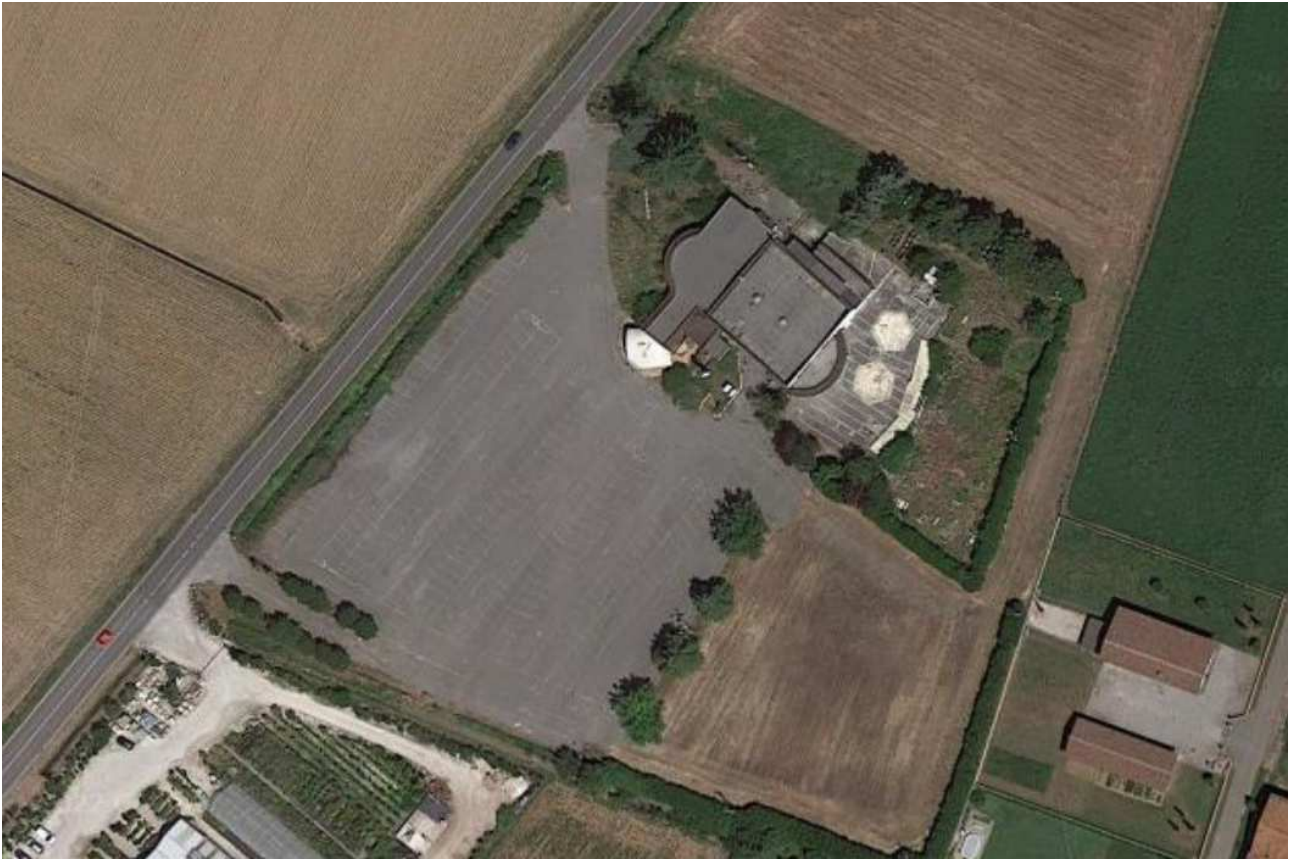
Fotografia satellitare dell'area in oggetto (fonte: google.maps)
