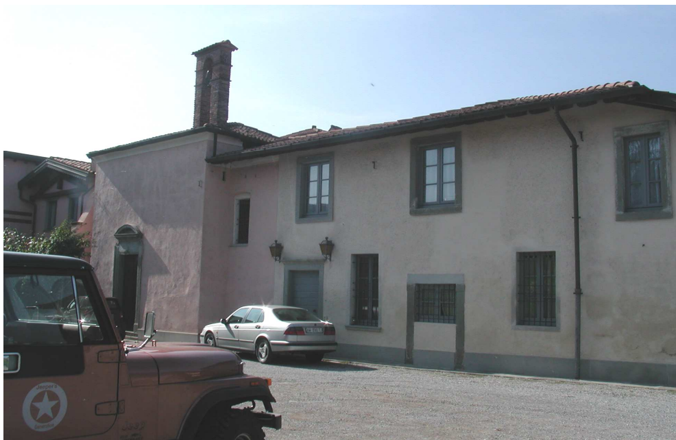
La cascina Ingussano con la chiesetta di S. Girolamo dopo il restauro
